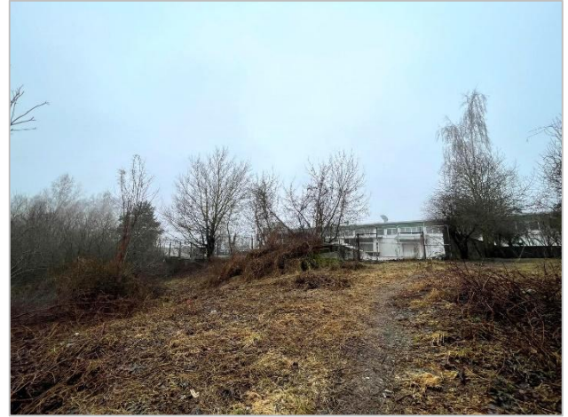
11. attēls. Attēla priekšplānā nekustamais īpašums "Piesīši", tukumā – apbūve Izstāžu ielā 9. Foto uzņemts 27.02.2024.
