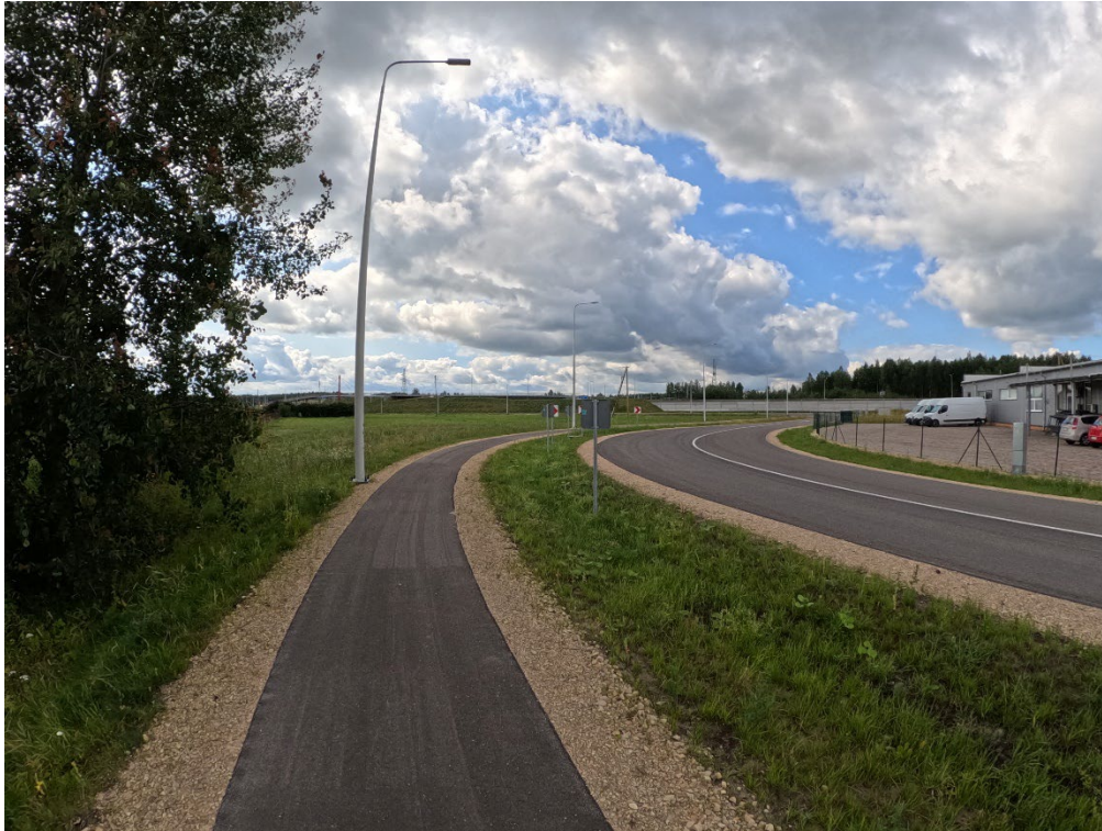
5.attēls. Skats no detālpilānojuma teritorijas virzienā uz valsts autoceļu A7
