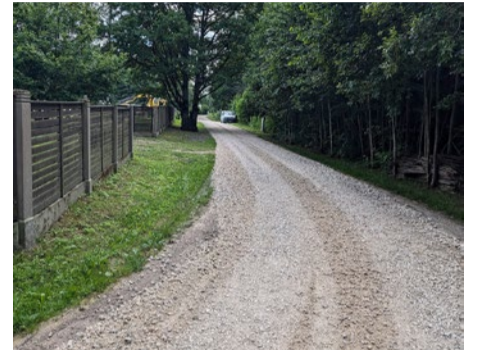
Rosmes ielā Jaunsilā uzbērtā papildu grants šķembru kārtā, kas uzlabos ceļa noturību.
