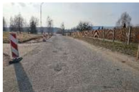
11. attēls. Odukalna ielas pārbūve.
