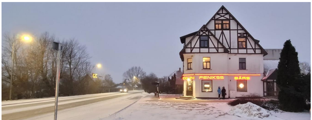
Fotofiksācija. Skats uz Detālplānojuma grozījumu teritoriju
