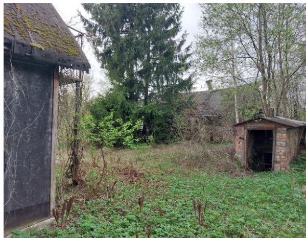
Attēls 6. Skats uz esošo apbūvi detālplānojuma teritorijā
