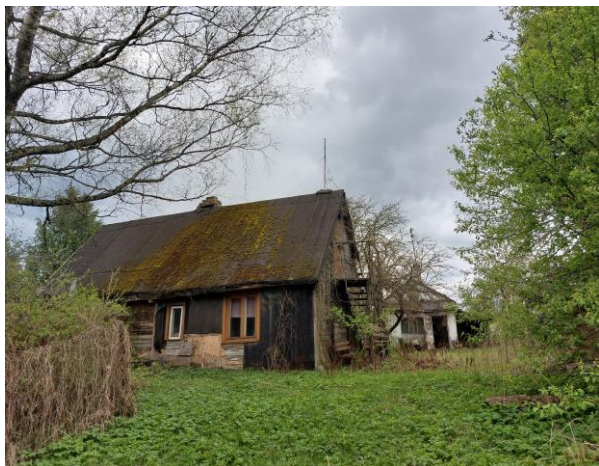
Attēls 5. Skats uz esošo apbūvi detālplānojuma teritorijā
