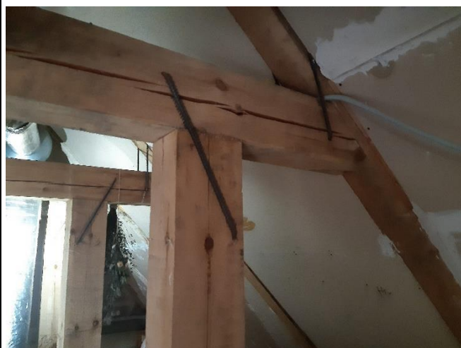
Foto Nr. 76 mainītās un protezētās jumta konstrukcijas
