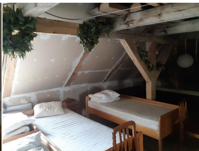
Foto Nr. 77 mainītās un protezētās jumta konstrukcijas
