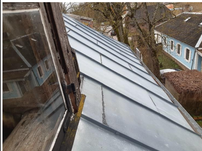
Foto Nr. 80 jumtas segums
