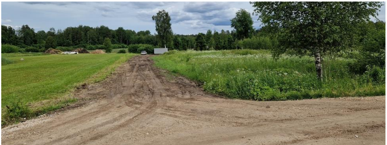
Fotofiksācija. Iebrauktuve no Silmaču ielas un ceļa servitūta teritorijā zemes vienībā "Jaunvētras"
