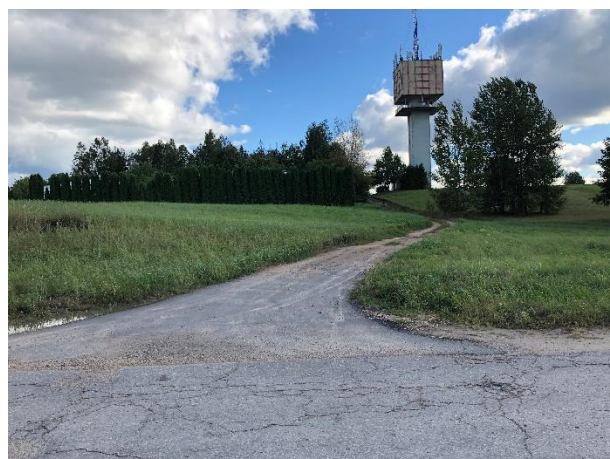
5. attēls. Detālpplānojuma teritoriju šķērsojošais celiņš (virzienā no Odukalna ielas uz nekustamo īpašumu ar kadastra apzīmējumu 8070 008 1136)
