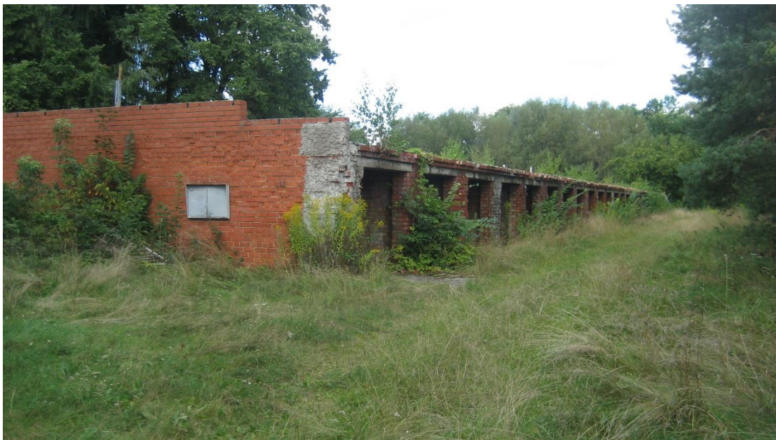
2.foto. Skats no plānojamās teritorijas centrālo daļu ar vēsturisko apbūvi.
