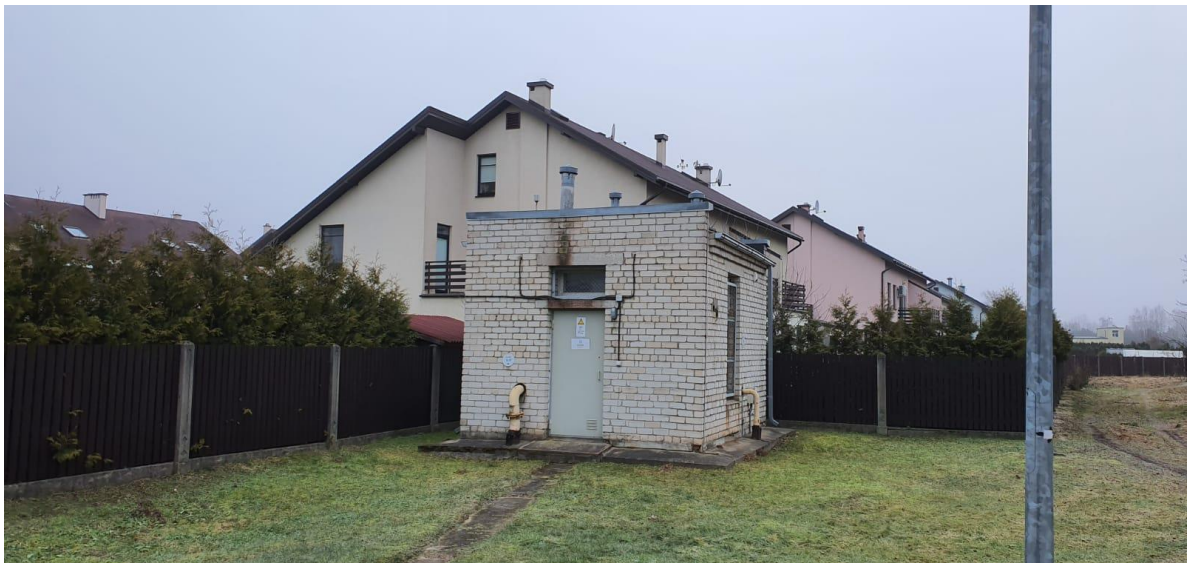
13. attēls. Gāzes regulēšanas stacija pie zemes vienības ziemeļu robežas (ārpus detālpļānojuma grozījumu teritorijas)
