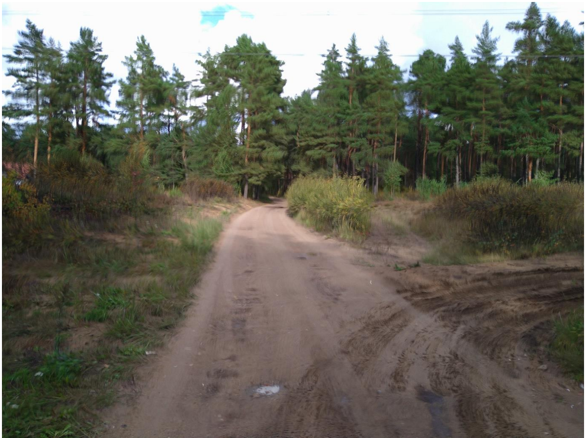
3. att. Skats uz ceļu ar grunts segumu
