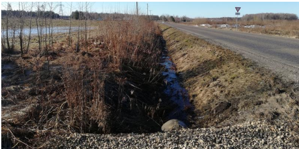
Fotofiksācija. Ziemeļu iela (pašvaldības ceļš) pie Detālplānojuma teritorijas un nobrauktuve
