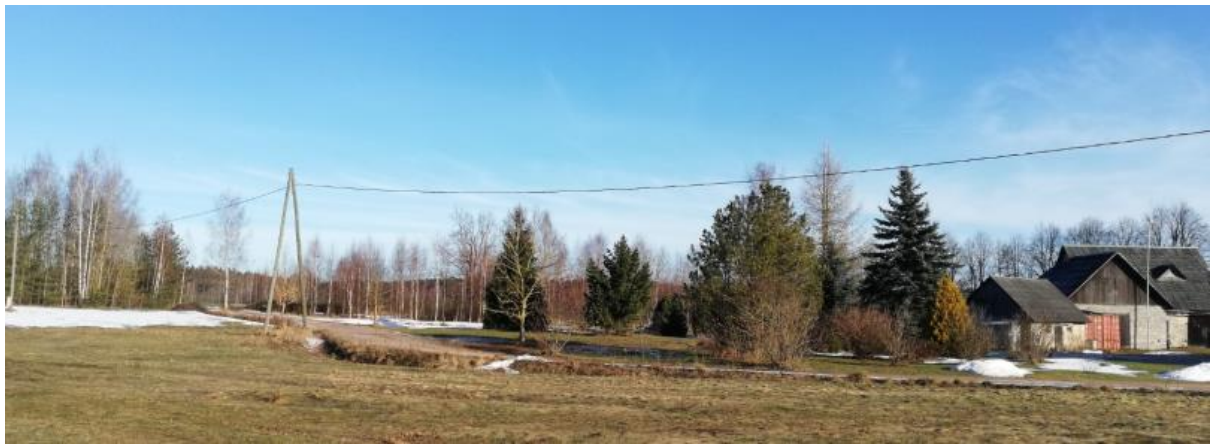
Fotofiksācija. 0,4 kV elektropārvades gaisvadu līnija Detālpilānojuma teritorijā
