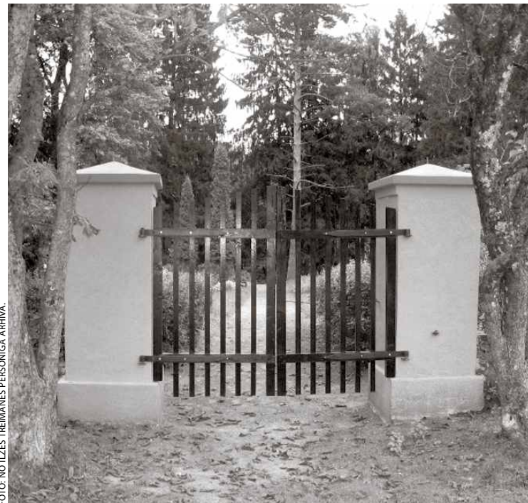
Šovasar pilnībā atjaunotie Trimdu kapu vārti
