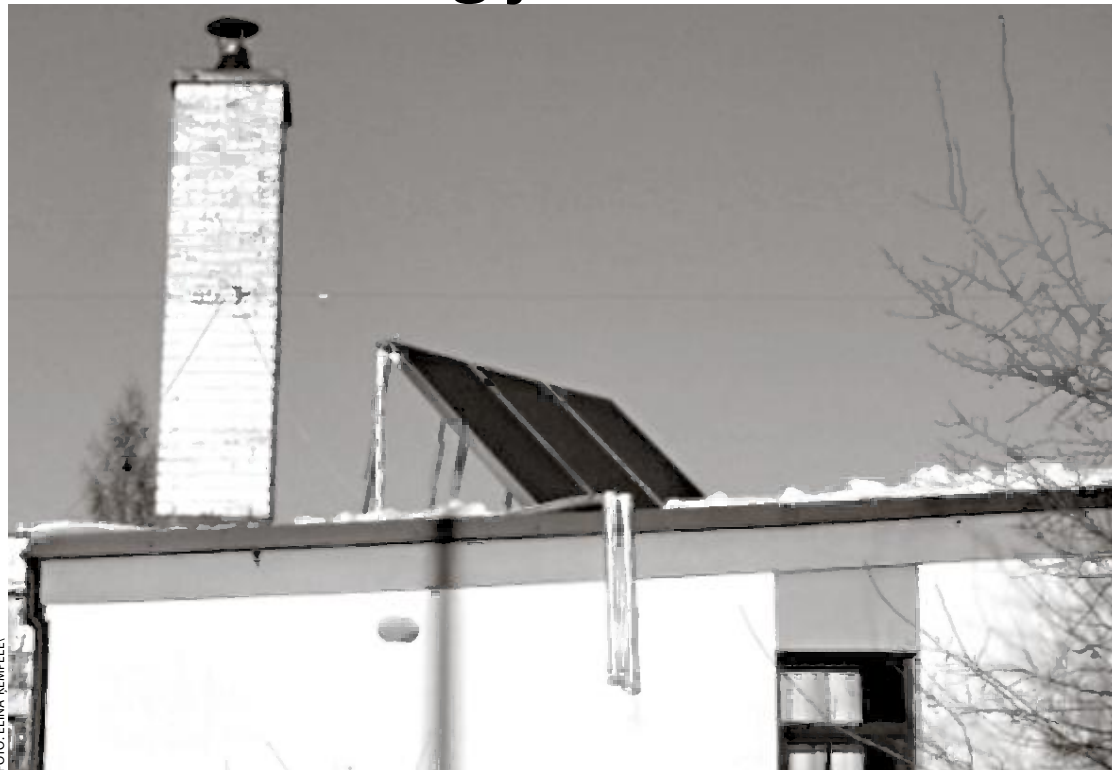
Saules kolektoru panelis uz "Millenium" ēkas jumta
