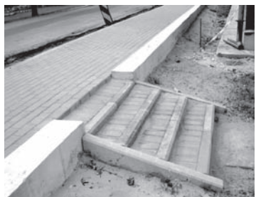
Ietves izbūve Daugavas ielā 2009. gada vasarā
