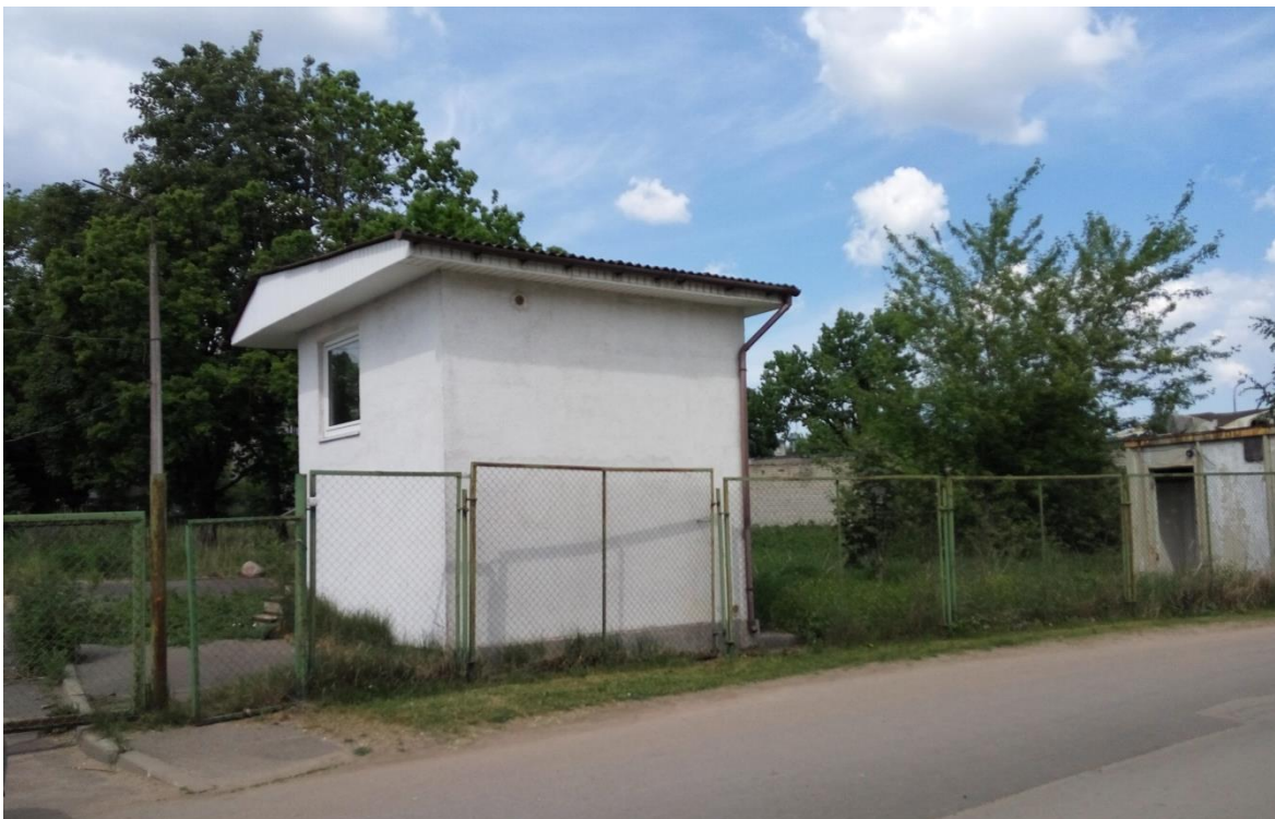
7.attēls. Lokālpilnījuma teritorijas rietumu daļa – saimniecības ēkas pie caurbrauktuves (zemes vienība "Ores")
