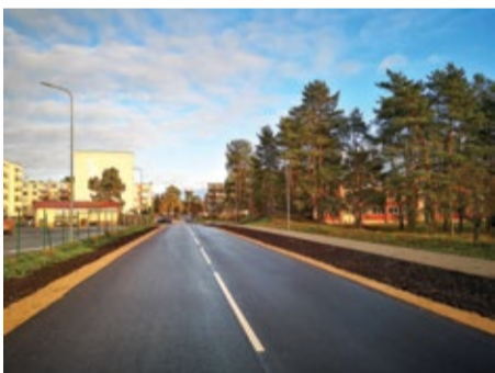
Šī projekta ietvaros pērn Baložos tika izbūvēta arī Jaunatnes iela ar asfalta segumu, gājēju ietve un jauns apgaismojums.
