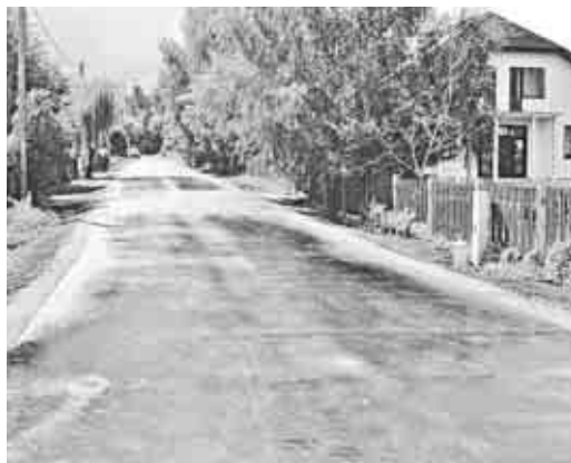
Tikko noasfaltētās Purmaļu un Dūņu ielas Rāmavā
