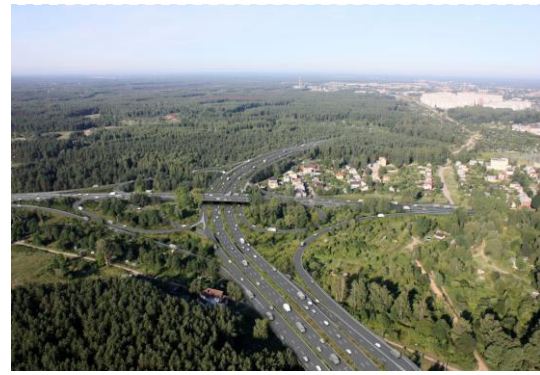
5.att. J.Čakstes gatves un Ziepniekkalna ielas šķērsojums pēc pieslēguma izbūves līdz Vienības gatvei.
