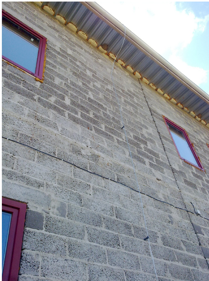
3.att. Neizveidoto lietusūdens notekcauruļu ietekme uz ēkas ārsienu
