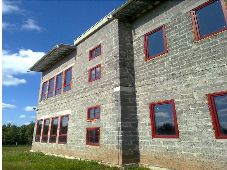
3.att. Neizveidoto lietusūdens notekcauruļu ietekme uz ēkas ārsienu
