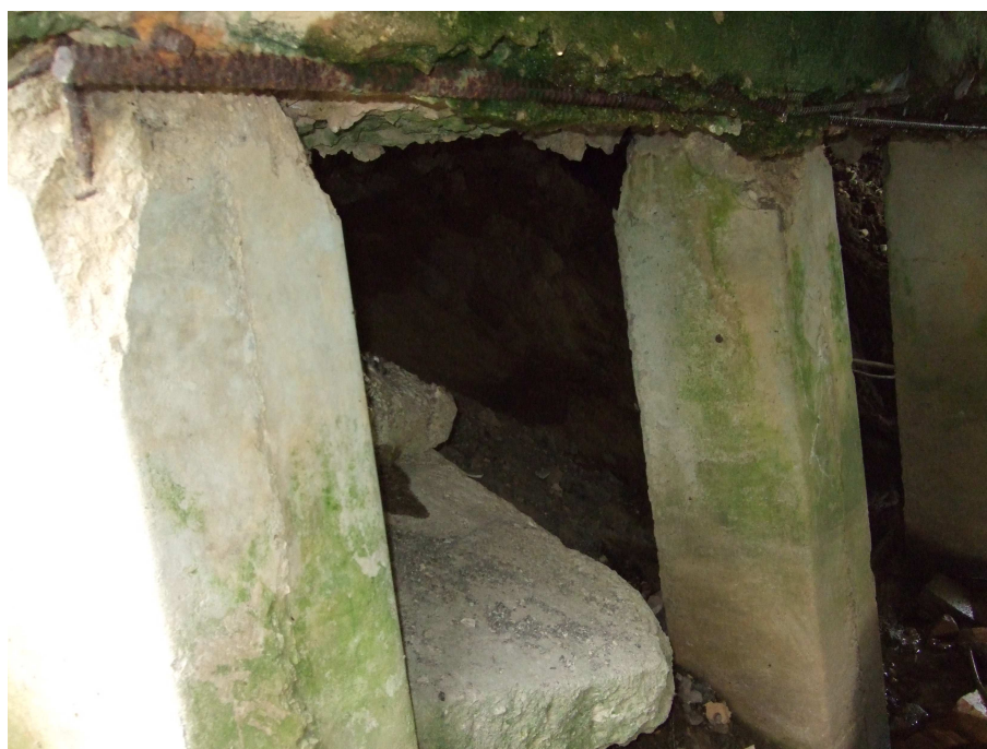
Bojāti pāļu gali kuri radošies to iedzīšanas laikā sasniedzot dolomītu. Bojāta balstu uzkala mitruma, nekvalitatīva betona, nepietiekamas aizsargkārtas dēļ.
