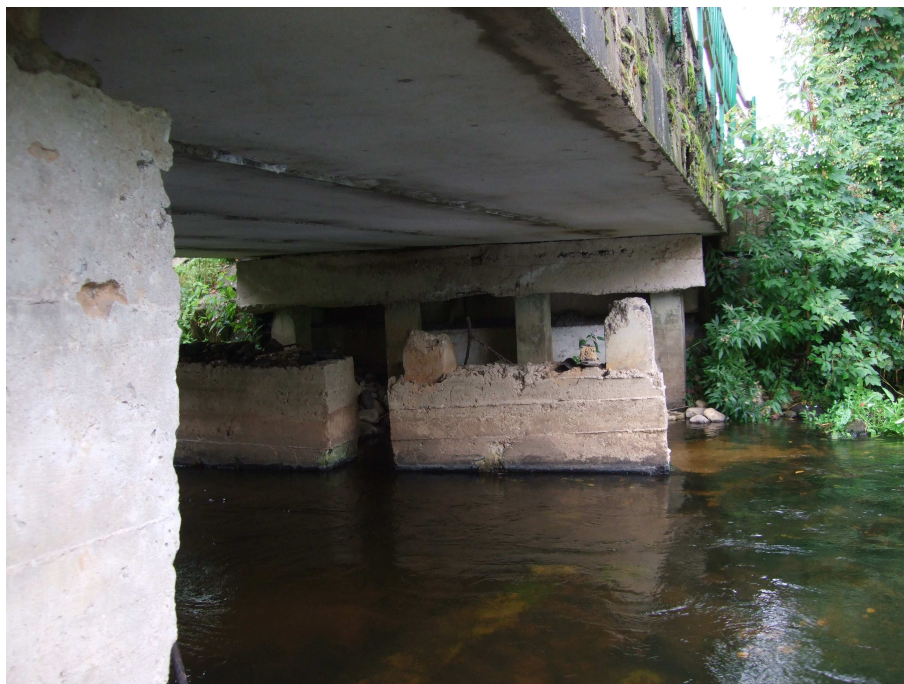
Skats uz tilta pātnēm un neizmantoto starpbalstu.
