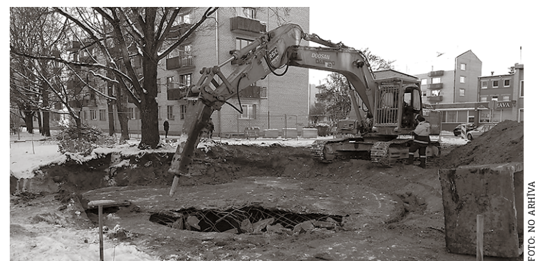
Tiek nojaukts bīstamais pazemes rezervuārs.
