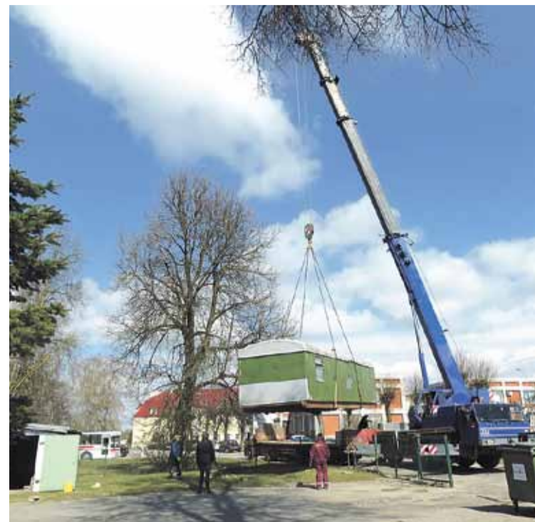
Būvniecības laukuma iekārtošana.
