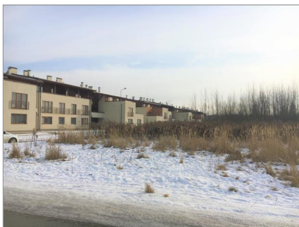
9.attēls. Skats uz detālplānojuma teritoriju priekšplānā un mazstāvu daudzdzīvokļu apbūvi nekustamajā īpašumā "Bērzavoti".
