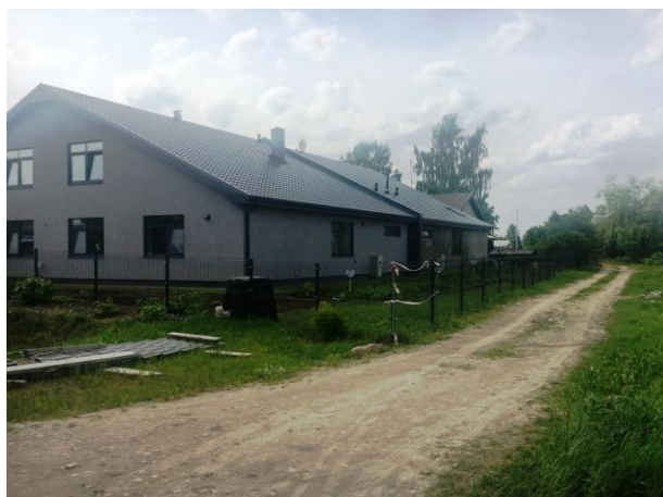
6.attēls, Detālpilānojuma teritorijas DR daļā esošais ceļa servitūts.
