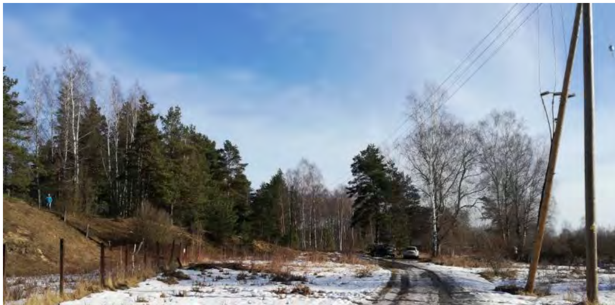
2.14.attēls. Fotofiksācija. 20 kV elektropārvades gaisvadu līnija gar Kalnu ielu
